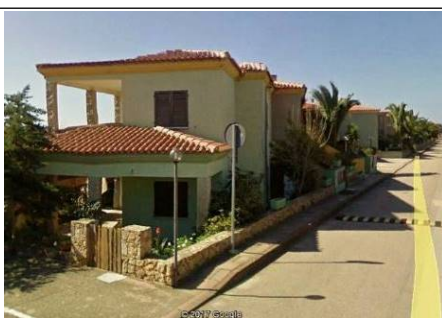
Apartmány TT 40P - ubytování CA PT
